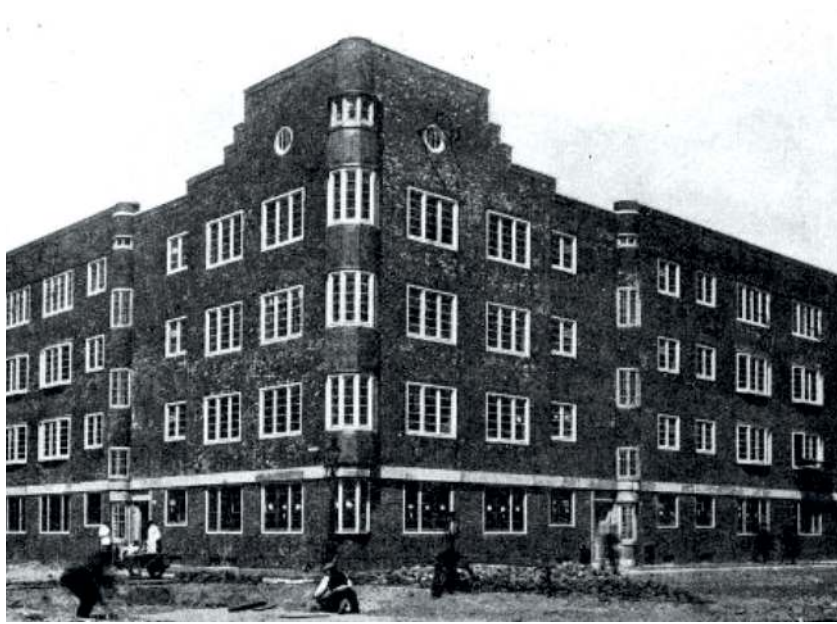
Hoek Banstraat (links) - Frans van Mierisstraat in 1923. (Foto: Bouwkundig Weekblad 1923).
